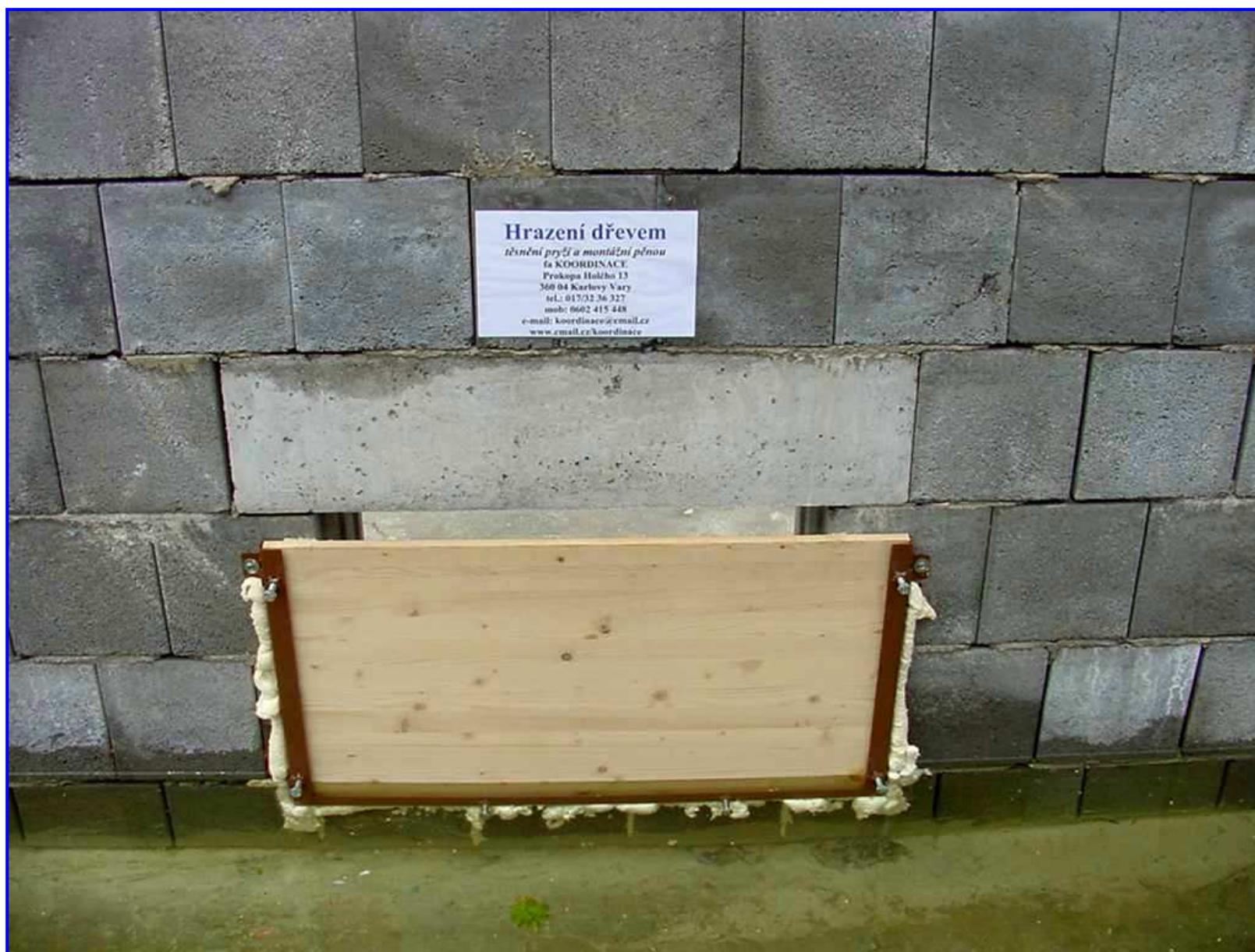
Hrazení dřevem – těsnění pryží a montážní pěnou
