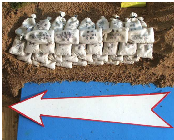
Obr.18 Překrytí koruny hráze
