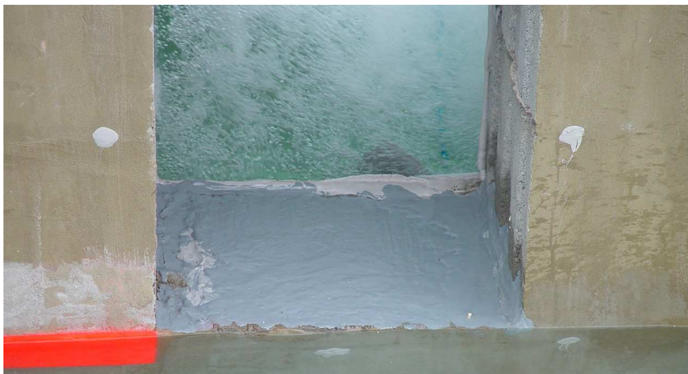
Hrazení okna plexisklem
