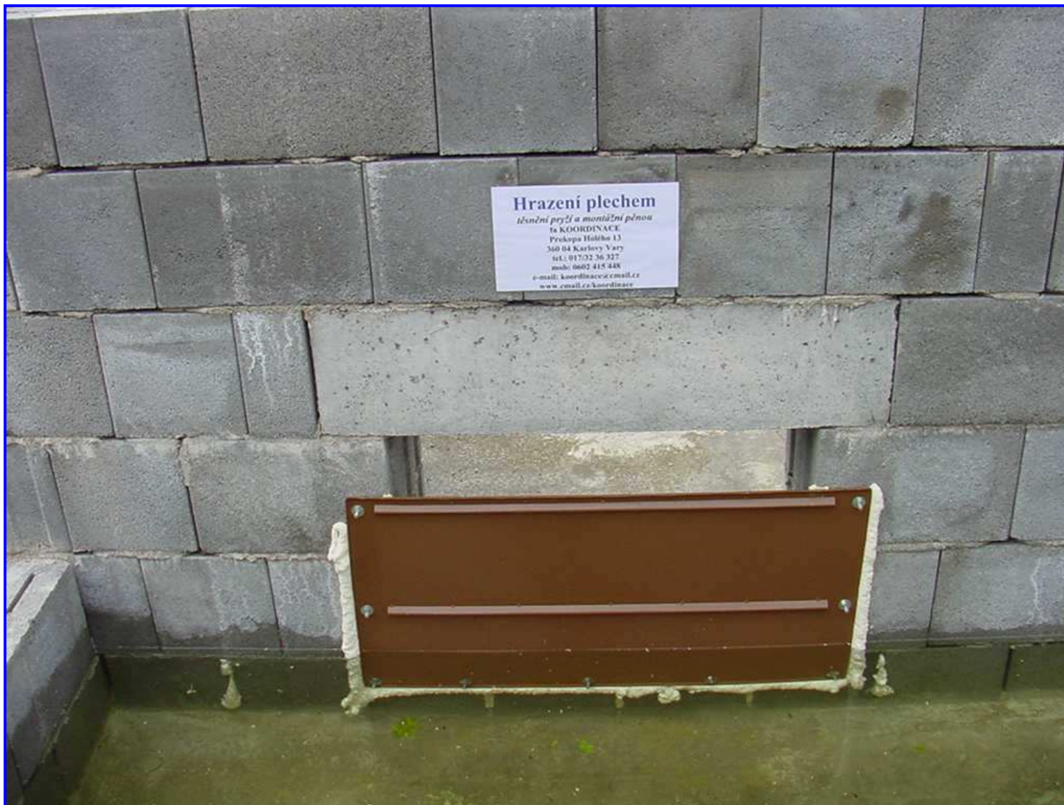
Hrazení plechem – těsnění pryží a montážní pěnou
