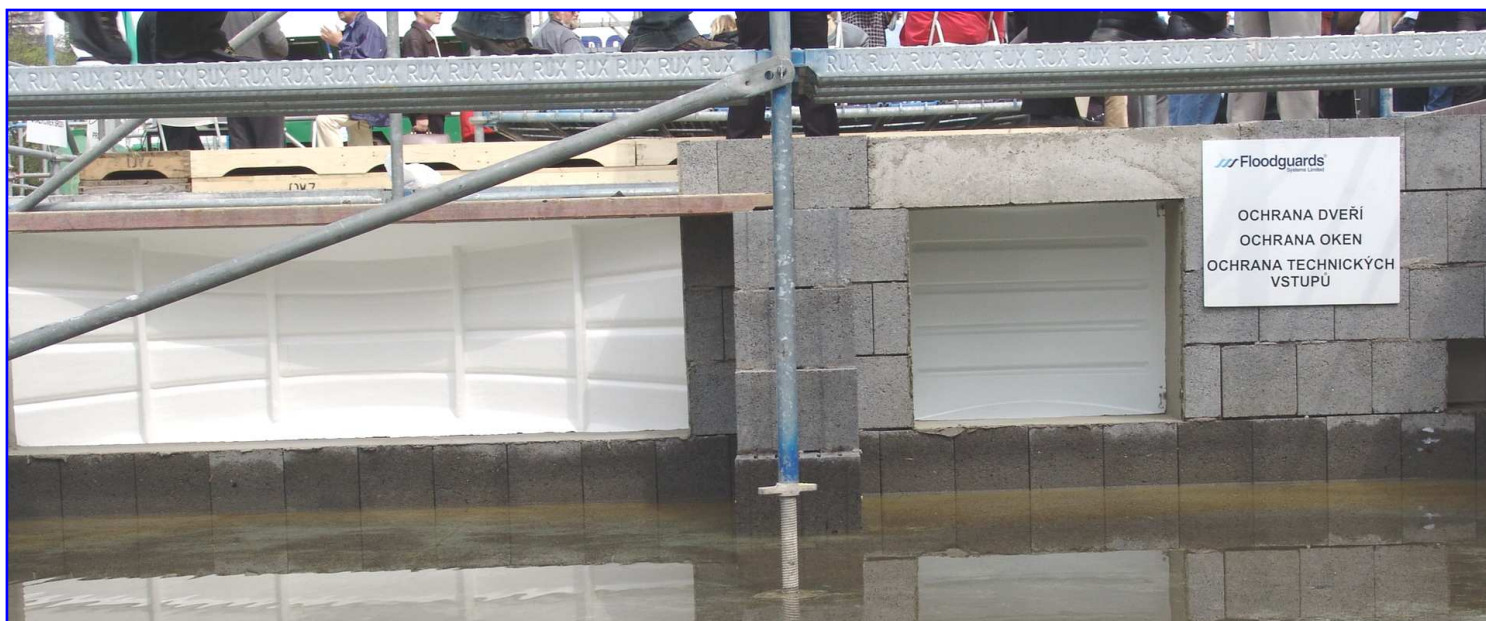
Ukázka hrazení otvorů – výrobku z Velké Británie
