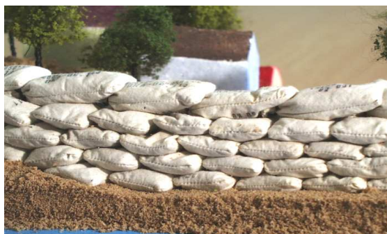
Obr. 11 Kladení pytlů nad sebe v jedné řadě
