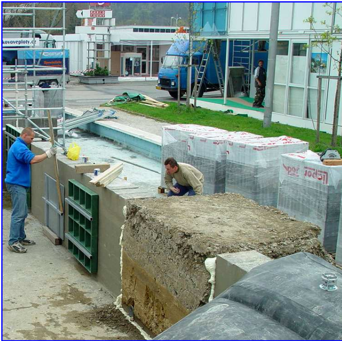
Příprava ochranných desek a upraveného sedimentu
