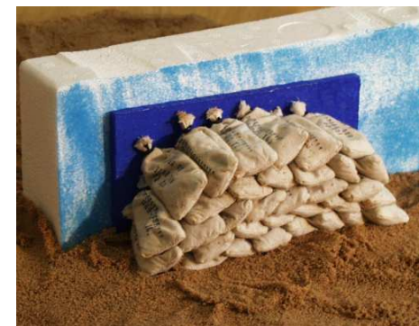
Obr. 26 Překrývání otvorů
