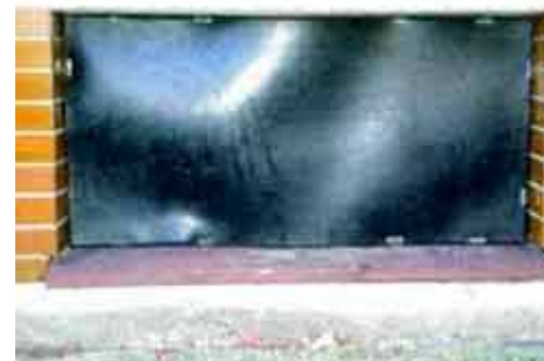
Okno s nasazeným rámem a těsnící gumou přichycenou pomocí pacek
