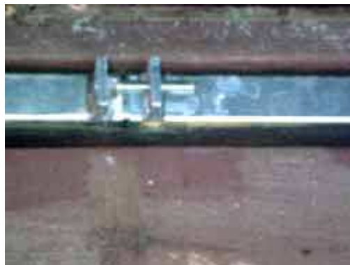
Detail roztahovacího šroubu
