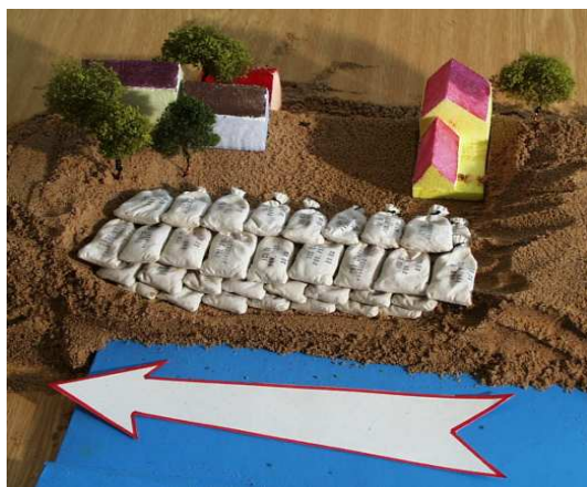
Obr. 17 Kladení pytlů víceřadé
