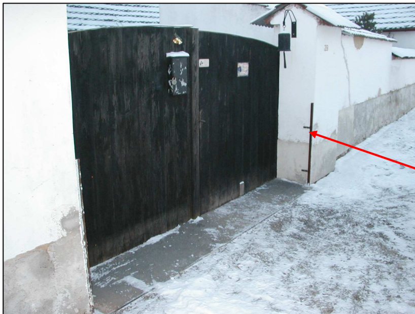
Žďár (u Protivína) č.p. 39, chalupa p Z.Macka, Předpřipravené profily pro zasunutí protipovodňové přepážky. Foto: leden 2003 – na fotografii je viditelná stopa po povodni v srpnu 2002.
