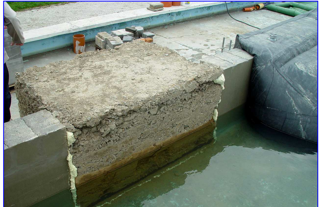
Sediment z vodoteče zušlechtěného vápnem s montážní pěnou
